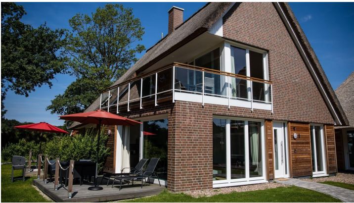
Frontalsicht Haus 3 (Luft) - © Residenz am kleinen Meer - Simon Eschen
