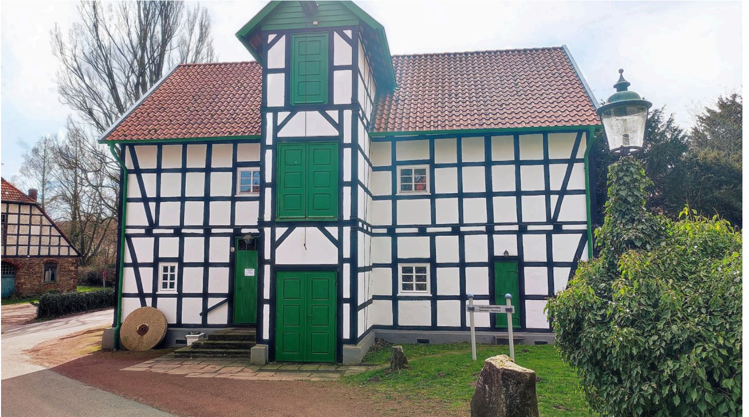
Gutswassermühle Bad Holzhausen
