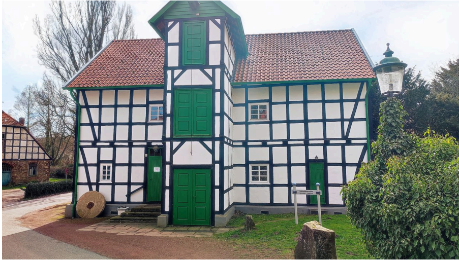
Gutswassermühle Bad Holzhausen
