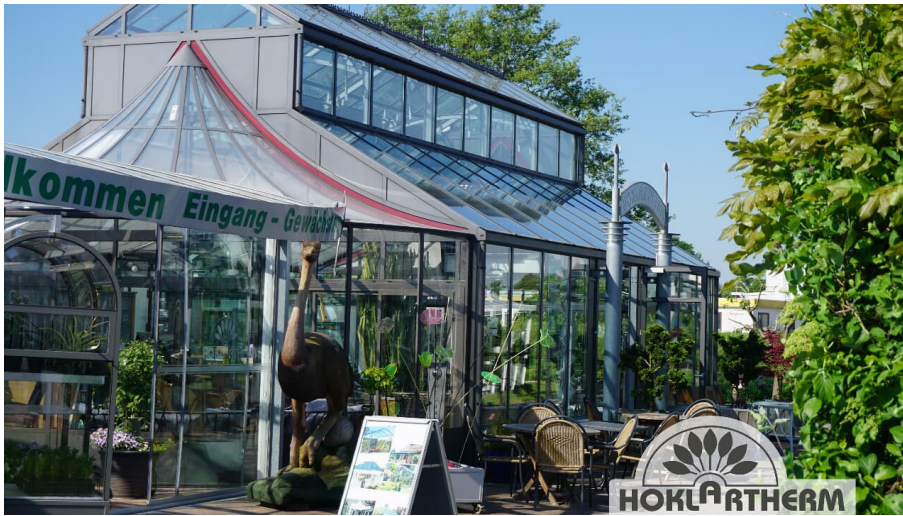
Orangerie Außenansicht - © Fa. Hoklartherm
