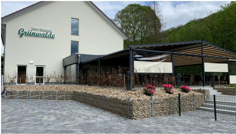
Halle-Aussenansicht-TeutoburgerWald-HotelRestaurantGrünwalde.jpg - © Hotel Restaurant Grünwalde
