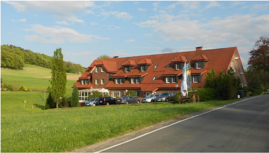
Außenansicht - © Hotel Rehkitz
