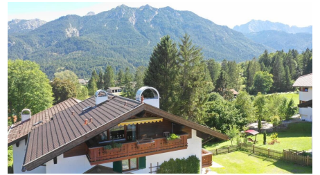
Blick auf Balkon von oben
