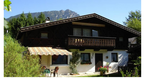
Haus Richtung Nord-Ost Richtung Kramer
