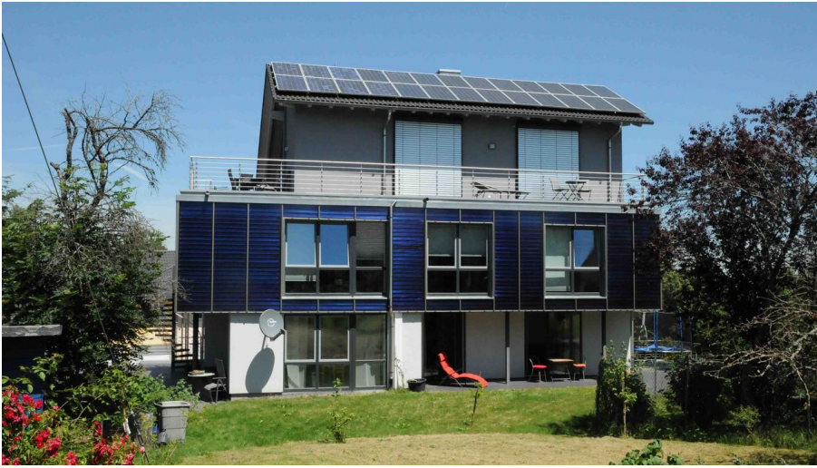
Im Untergeschoss befindet sich die Fewo Grieshaber - © Grieshaber
