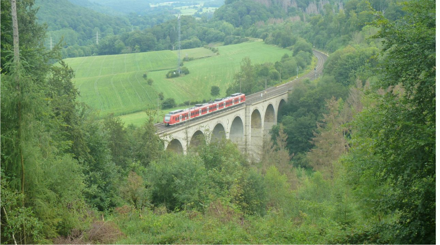
Blick von der Aussichtsplattform Dunetal auf den Kleinen Viadukt - © Karl Heinz Schäfer, Tourist Information Paderborn
