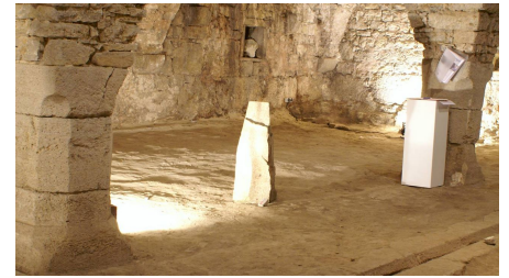
Großer Gewölbekeller in der Burg Dringenberg - © Heimatverein Dringenberg
