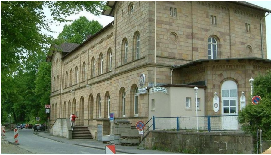
Bahnhof Bad Driburg - © DB Station&Service AG
