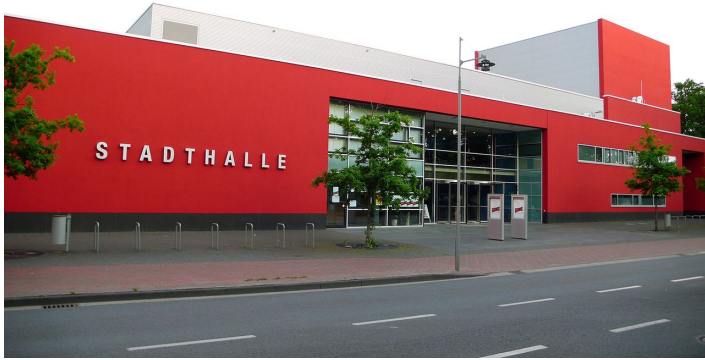
Stadthalle Gifhorn Eingang.JPG
