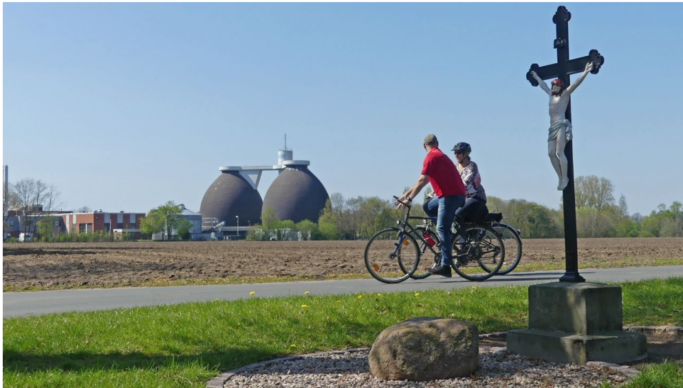
Faultürme der Kläranlage Paderborn - © Karl Heinz Schäfer, Tourist Information Paderborn / Verkehrsverein Paderborn e.V.
