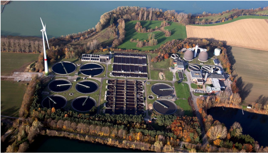
Luftaufnahme der Kläranlage Paderborn - © Stadtentwässerungsbetrieb Paderborn (STEB)
