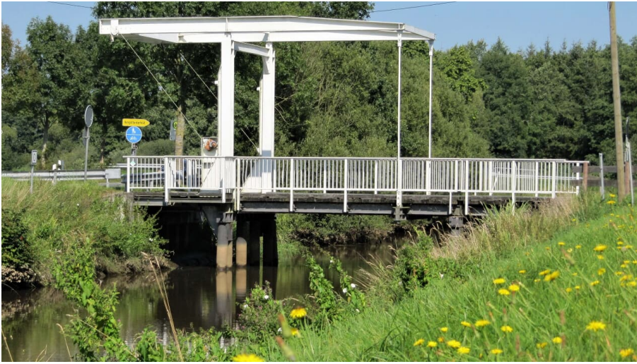
Brücke am Nordloh Kanal - © Sandra Hinrichs
