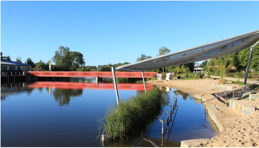
Kneippbecken - © Gartenschauпарк Rietberg GmbH
