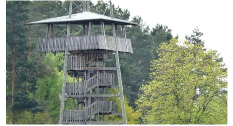
Aussichtsturm im Parkteil Mitte - © Gartenschaupark Rietberg GmbH
