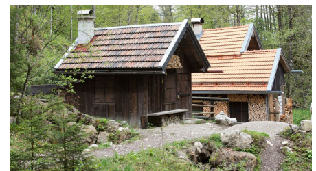
Schleifmühle Unterammergau - © Ammergauer Alpen GmbH
