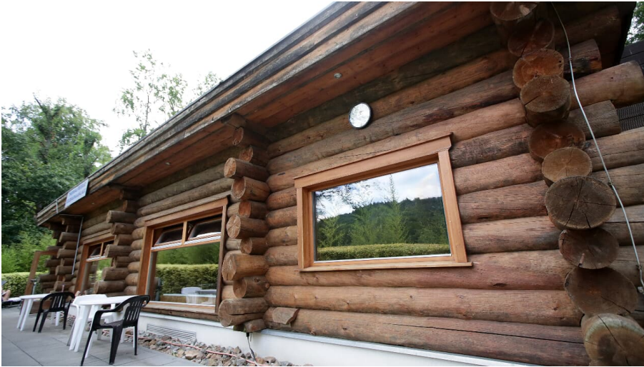
072HR - Schlangenbad - Kelosauna-Anlage.JPG - © Heiko Rhode
