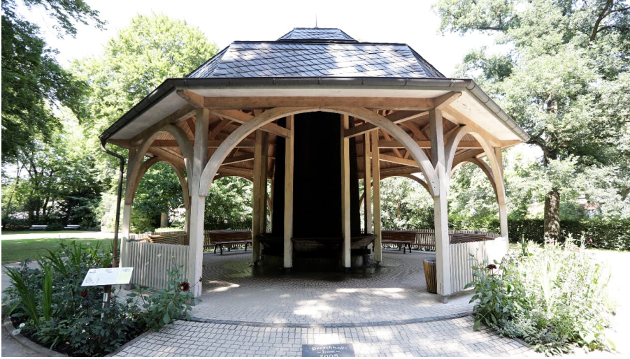
033HR - Bad Salzschlirf - Kurpark Gradierwerk.JPG - © Heiko Rhode
