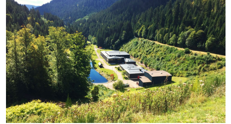
Kinzigtalsperre Kraftwerk und Verwaltungsgebäude - © Pro-cycl - Christian Ludewig, www.pro-cycl.de
