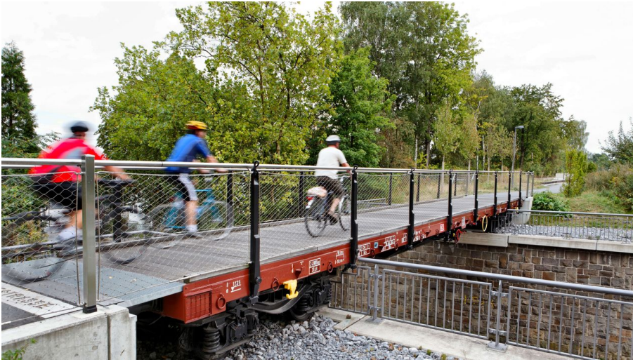
Waggonbrücke auf dem PanoramaRadweg niederbergbahn in Heiligenhaus - © Kreis Mettmann, Martina Chardin
