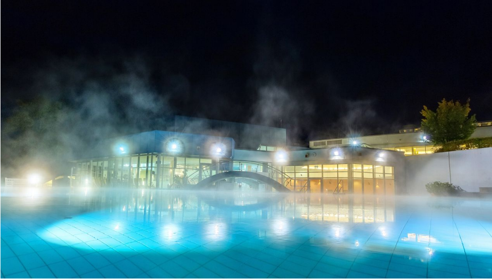
Thermalbad Aukammtal außen - © Joerg Halisch "Alle Rechte vorbehalten"
