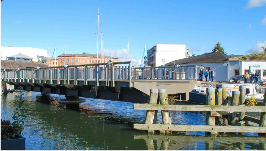
Langenkanalbrücke - © TZ HST
