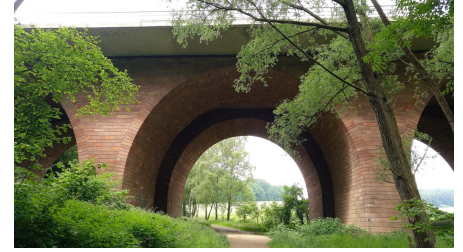
Deutschlands älteste Autobahnbrücke über Finnebachtal - © Teutoburger Wald - Bad Salzufen - Kerstin Paar
