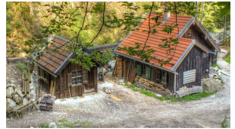
Wetzsteinmühle - restaurierte Mühle von Außen - © Thorsten Unsel, Günter Warmuth
