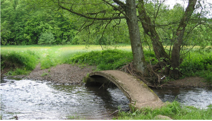
Brücke am Eichköppel
