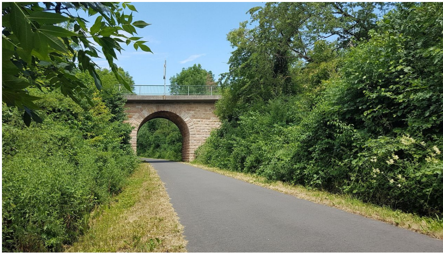
Bahnradweg Rotkäppchenland Brücke - © Heidrun Englisch
