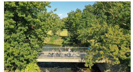
Emmerbrücke Bad Pyrmont - © Bad Pyrmont Tourismus GmbH - info@badpyrmont.de
