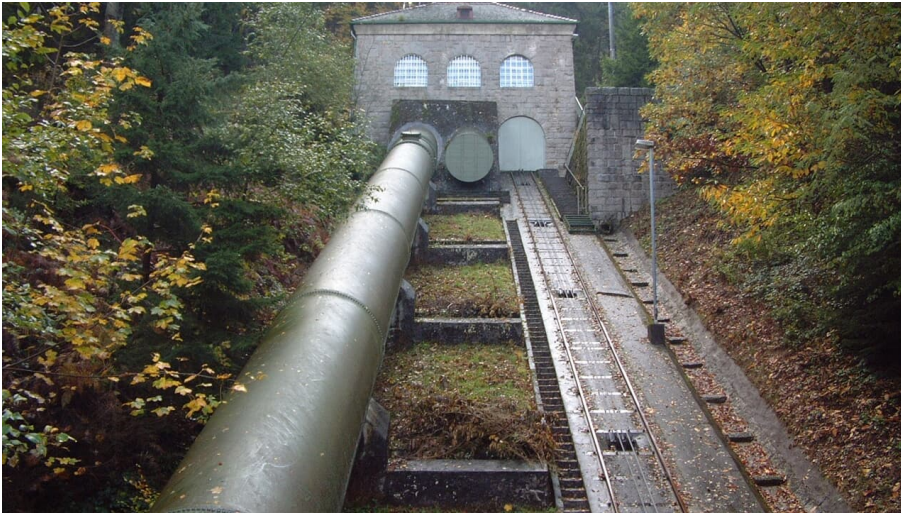
Forbach-Oberes Wasserschloss - © Thomas Hudeczek, Nationalparkregion Schwarzwald - Baiersbronn / Murgtal
