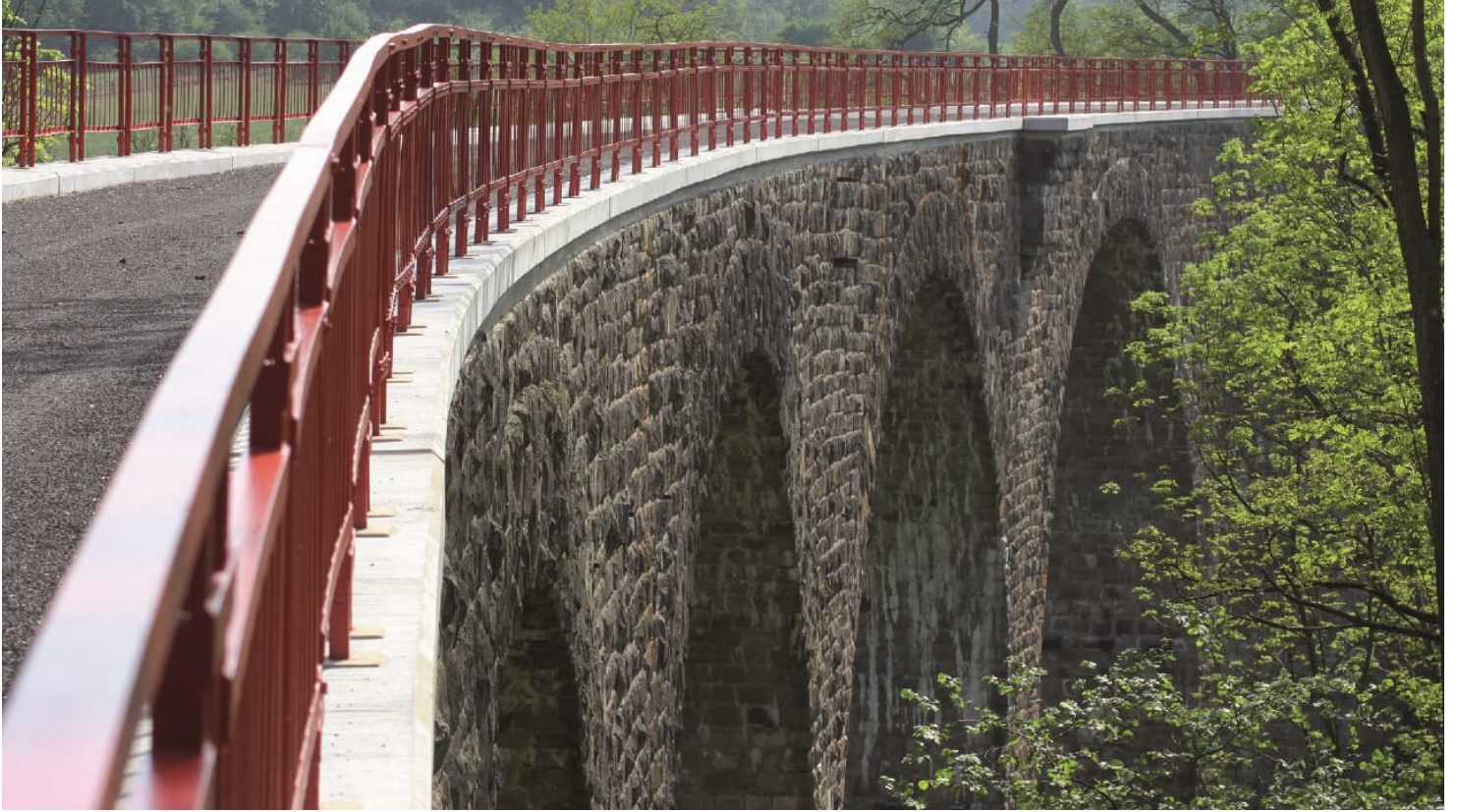
Viadukt in Heiligenhaus - © Stadt Heiligenhaus
