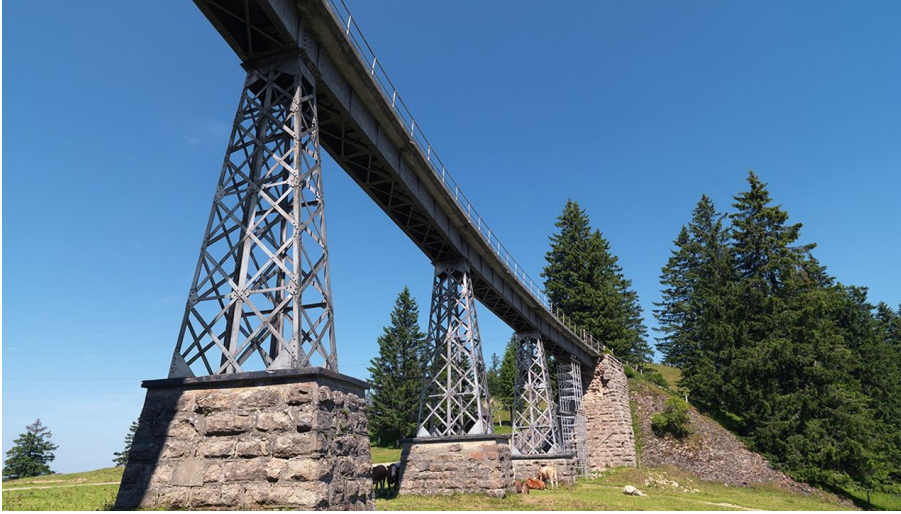
Brücke Unterstetten - © Schwyzer Wanderwege
