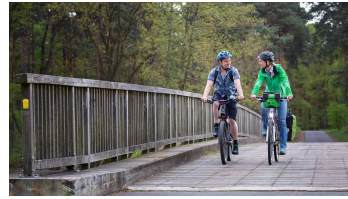
Radwegebrücke Mönchwinkel Spreeeradweg - © Seenland Oder-Spree/Florian Läufer, Lizenz: Amt Burg (Spreewald)
