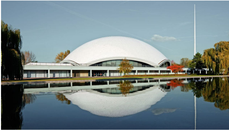
Jahrhunderthalle Frankfurt Höchst - © Jahrhunderthalle Frankfurt Höchst
