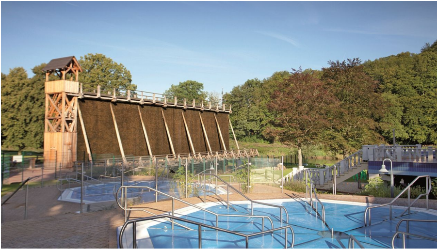
Weser-Therme Gradierwerk und Aussenbecken - © Bad Karlshafen GmbH
