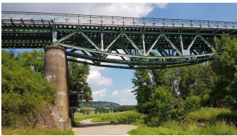
nethe_eisenbahnbruecke_ottbergen.jpg - © Stadt Höxter, Stephan Berg
